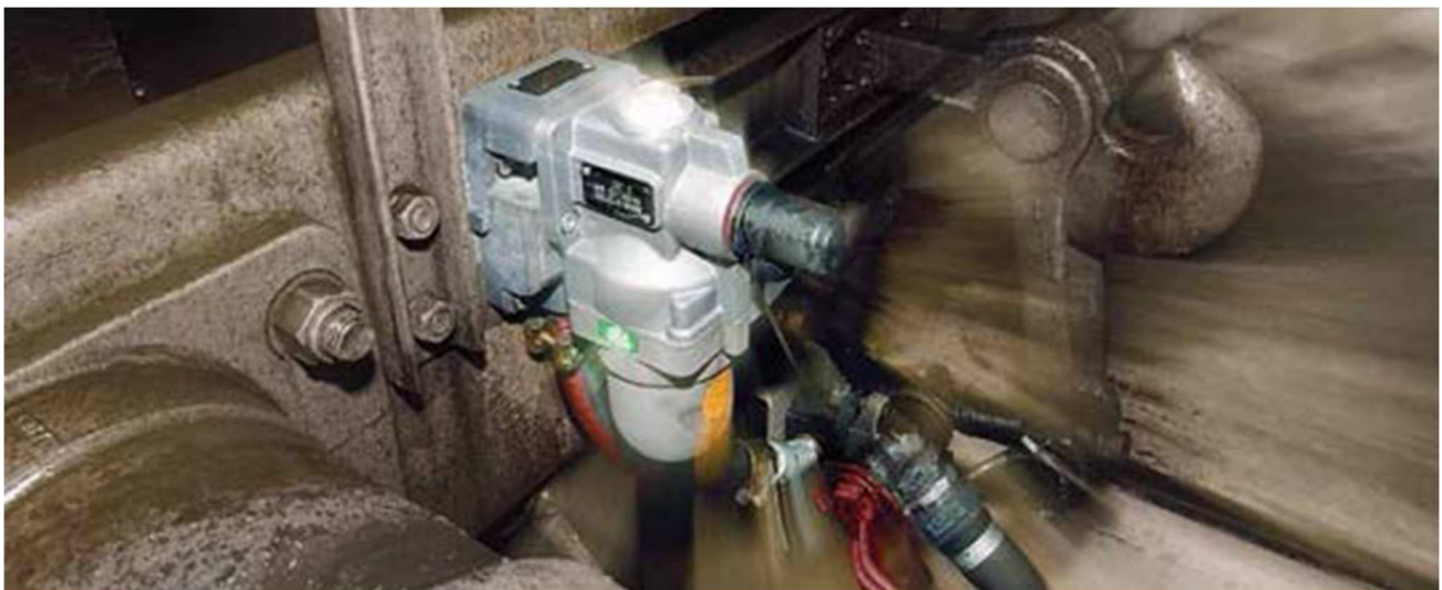
Figura 8.2 - Installazione di un rilevatore di deragliamento su un carro merci
